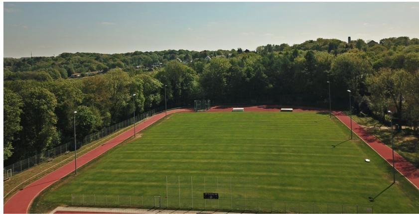
Bei der Sanierung wurde eine Basisschicht aus Ziegelsplitt, die mit einem speziellen Bindemittel gemischt und mit Ziegelmehl abgestreut wird, aufgetragen. Auch die Drainage wurde verbessert. Eine Vollsperrung war nötig um großflächig die Arbeiten ausführen zu können und die Schichten trocknen zu lassen. Das sonnige Wetter der letzten Wochen kam der Dauer der Sanierung sehr entgegen.
